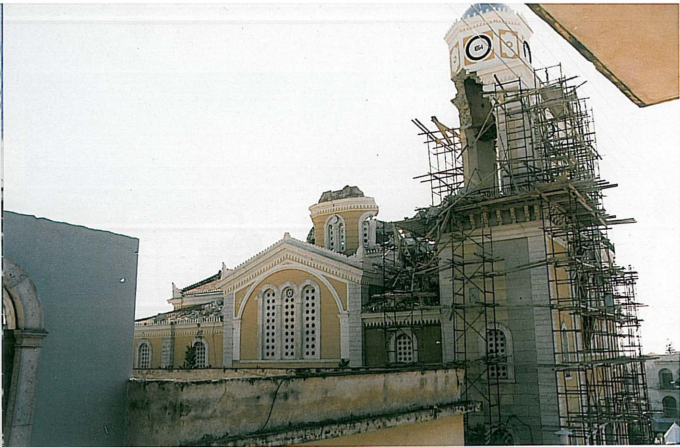
Αποψη των επισκευών του Μητροπολιτικού Ναού της Υπαπαντής του Σωτήρος, στην Καλαμάτα
