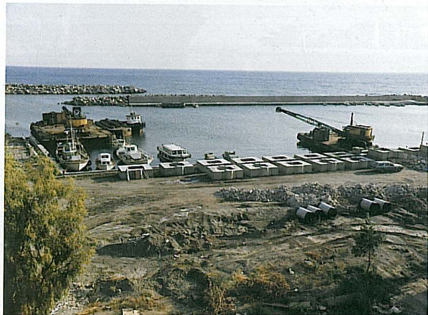
Αποψη από τα έργα κατασκευής της Μαρίνας Καλαμάτας.
