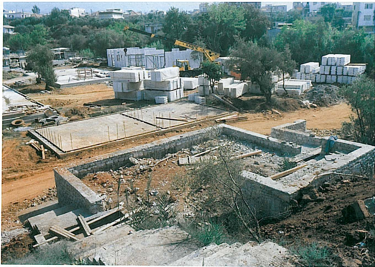
Αποψη από τα έργα διαμόρφωσης του Δυτικού Κέντρου Γειτονιάς.
